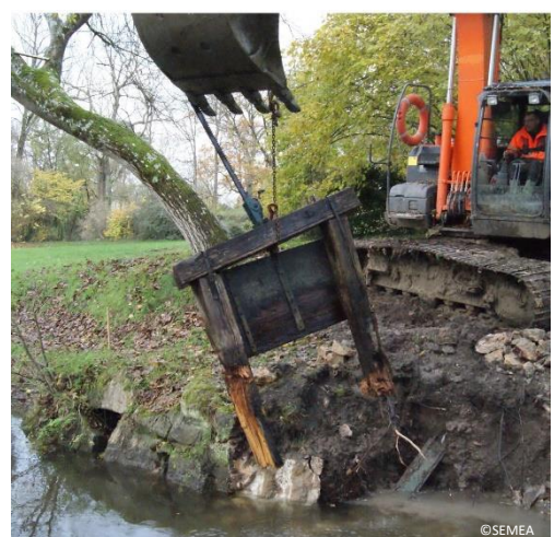
Le retrait de la vanne du plan d'eau amont (SEMEA, 2019)
